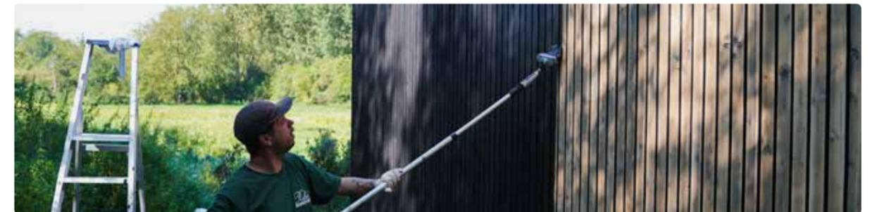
Die besten Ergebnisse erzielen Sie mit DuroGrit, wenn Sie das Produkt mit einem **weichen, synthetischen Pinsel für Produkte auf Wasserbasis** auftragen.
